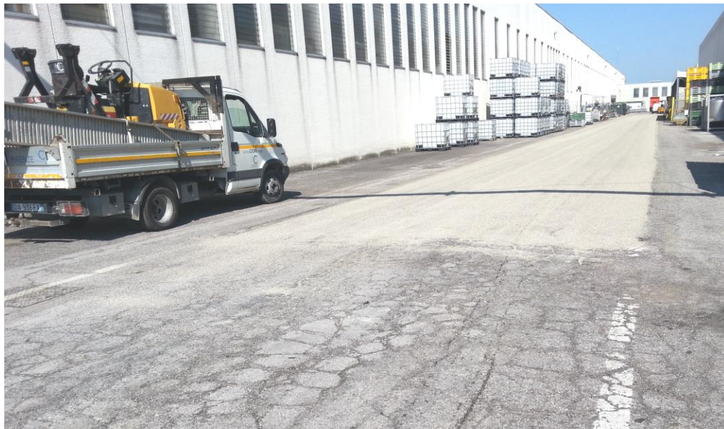
Ripristino pavimentazione asfaltica presso stabilimenti YOGA 2015
