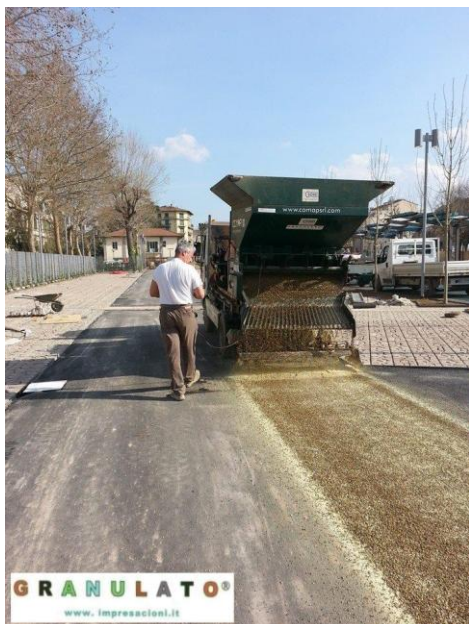
STESURA 1° STRATO DI GRANIGLIA CON MICROCOMBINATA
