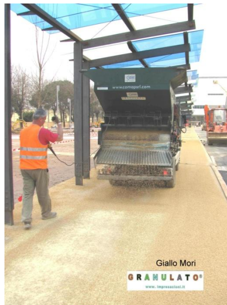
STESURA 2° STRATO DI GRANIGLIA CON MICROCOMBINATA
