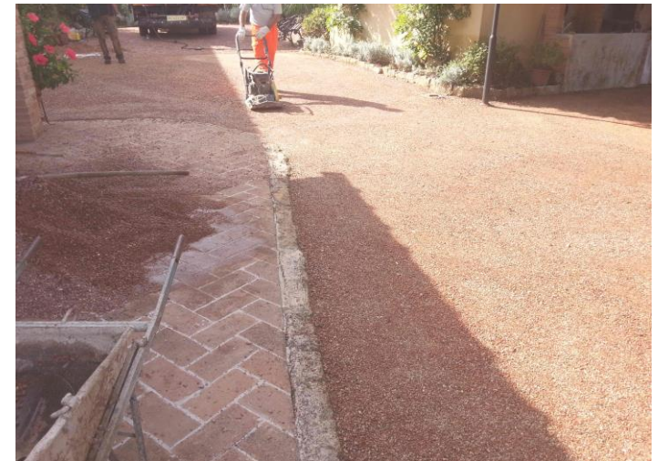
Costipazione con "piastra Vibrante" del 1° stato
