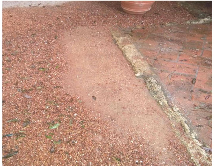
Esempio dopo rimozione eccessi di graniglia
