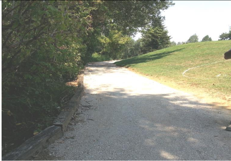
Vialetti su fondo in "stabilizzato calcareo" .....
