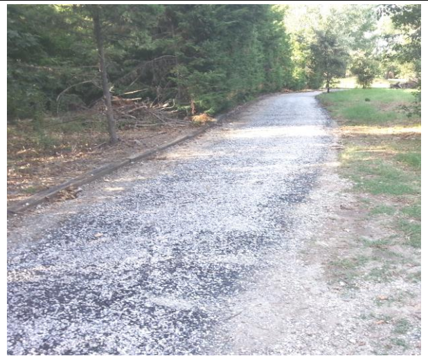
1° strato con inerte Ø 16/20 ed emulsione al 60%
