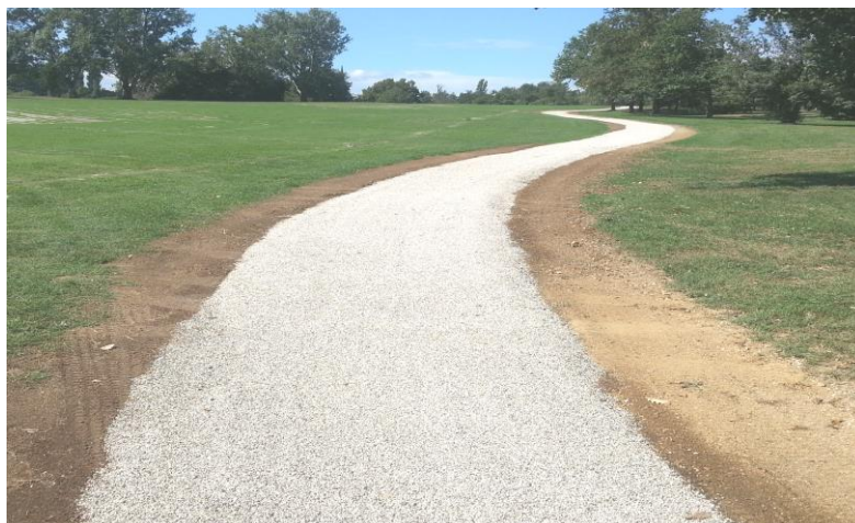
2° Strato con inerte Ø 10/12 ed emulsione al 65%
