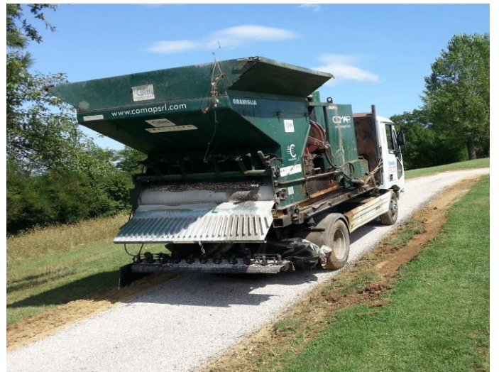
3° Strato con risetta Ø 3/5 ed emulsione al 65%
