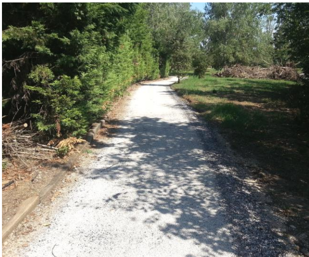
2° Strato con inerte Ø 10/12 ed emulsione al 65%
